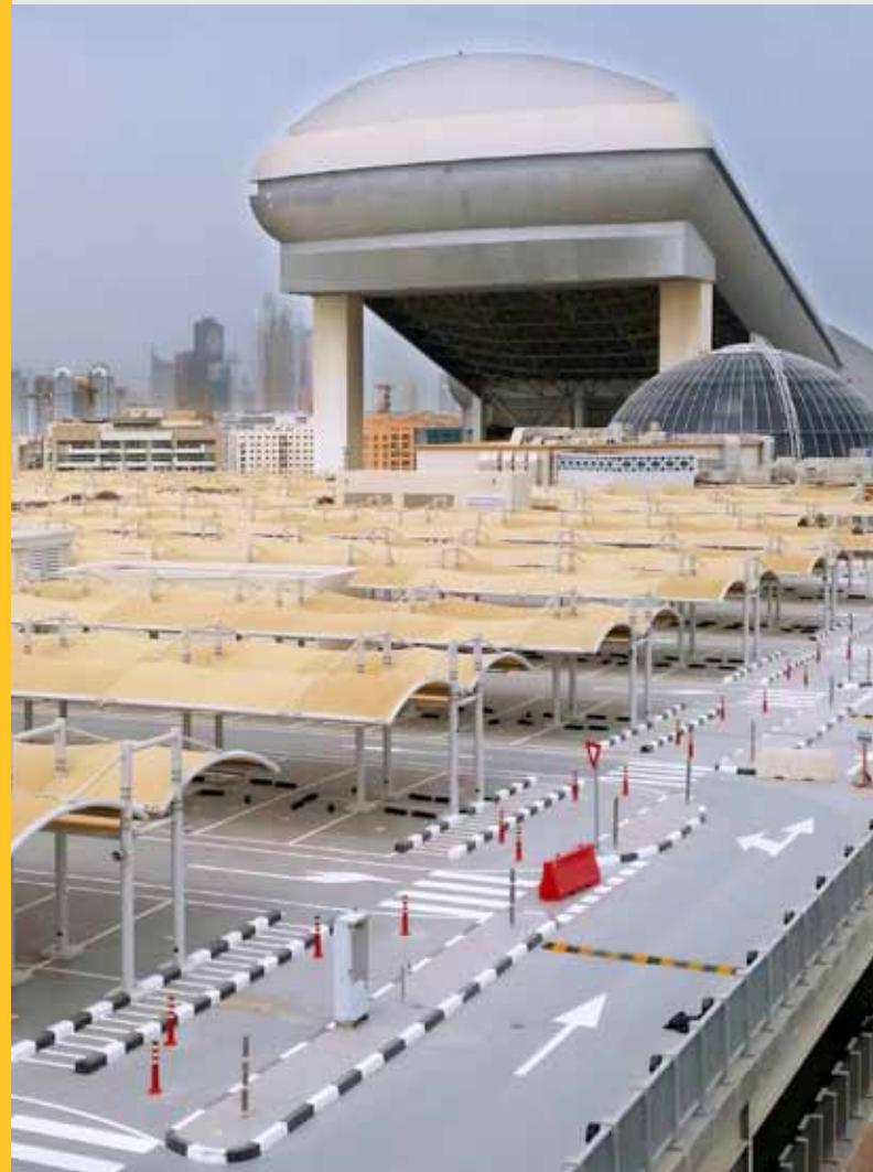
مياكل لأسقف موقف السيارات المركبة في مول الإمارات - المستوى ٤ الاستشاري: هولفورد وشركاه، دبي المقاول: خان صاحب للهندسة المدنية Roof Car Park Structures installed at Mall of Emirates Level 4 Consultant : Holford Associates, Dubai Contractor : Khansaheb Civil Engineering
