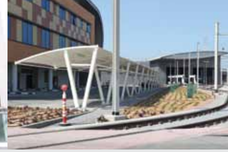
مشروع ترام دبي - مياكل مظلات هيئة الطرق والمواصلات لمواقف السيارات انسجة البولي كلوريد الفينيل، فيراري ٢، فلوتوب تي-٢، الاستشاري: سيسترا، دبي Dubai Tram Project - RTA Shade Structures for Car Park PVC Fabric, Ferrari 1302 Fluotop T2 Consultant : Systra, Dubai
