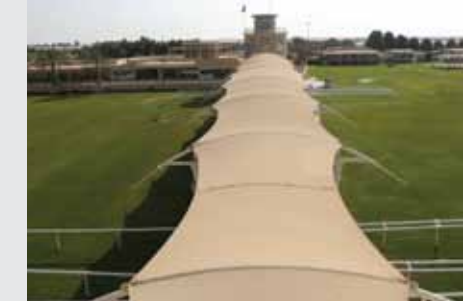
مياكل المظلات في قرية دبي للقرية الاستشاري: المكتب الهندسي Dubai Endurance Village Shade Structure Consultant : Engineering Office
