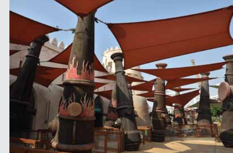
أعمال التظليل والكافين - مشروع حديقة ياس للألعاب المائية الاستشاري: ديليو إس أتكينز Yas Water Park Project - Shade Works & Cabanas Consultant : WS Atkins
