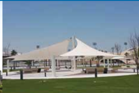
هياكل المظلات في ند الشبا الاستشاري الخاص بمواد "متعدد الترافلوربوليثيلين" : دار الهندسة Shade Structure at Nad Al Sheba PTFE Fabric Consultant : Dar Al Handasah
