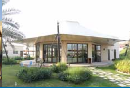
مظلة سقف لأحد المجالس في دبي الاستشاري: المكتب الهندسي Roof Top Shade at a Majlis in Dubai Consultant : Engineering Office
