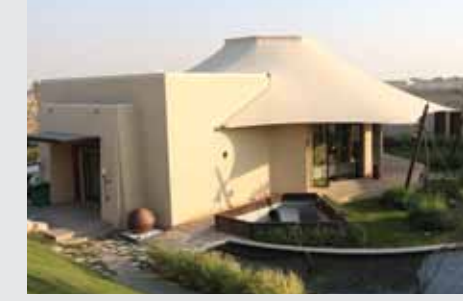
منطقة المجلس، المكون من خيمة مصنوعة من مادة البولي كلوريد الفينيل في منشأة هايبر ماركت في مجمع دبي للاستثمار الاستشاري: المكتب الهندسي Majlis Area PVC Tent at a Hypermarket facility in Dubai Investment Park Consultant : Engineering Office
