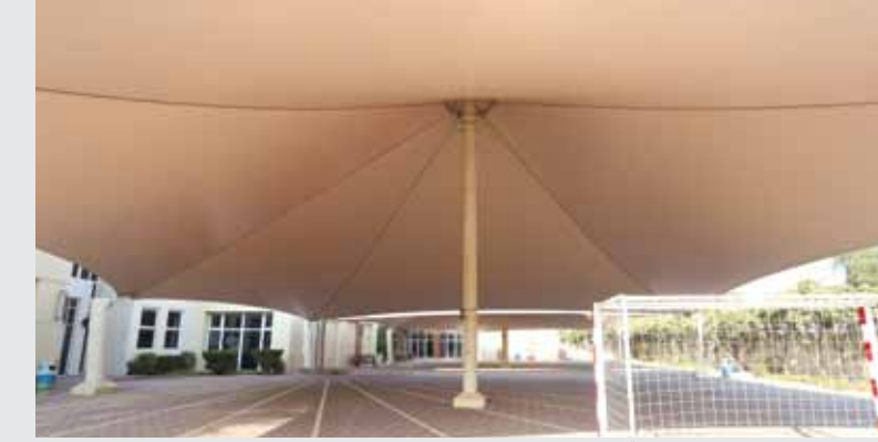
مبنيك تظليل مصنع من البولي فينيل كلوريد لتمام مدرسي في الرشدية - دبي الاستشاري: عارف وهن طوق PVC Courtyard Shade Structure, Al Rashidiya, Dubai Consultant : Arif & Bintook
