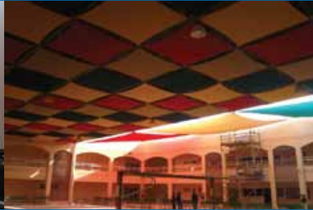
مظلات شرعية مركبة على هيكل مؤطر بمساحة فضاء، برنامج أبوظبي لمدارس المستقبل النموذجية منشأة لصالح شركة أبوظبي للخدمات العامة مساندة Sail Shades fitted into a Space Frame Structure at Abu Dhabi Future Model School Program for Musanada
