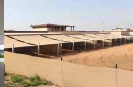
مظلات حظائر الكلاب بأحد المرافق في ند الشبا الاستشاري: المكتب الهندسي Kennel Shade at a Facility in Nad Al Sheba Consultant : Engineering Office
